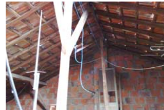
Fig.8 - Parede do prédio em tijolo e cimento.
