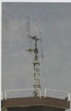
A estação de comando e controlo do PoSAT-1. No caso do satélite português as antenas não são parabólicas (a antena helicoidal é a de recepção, a que parece uma antena de televisão é a de emissão).
