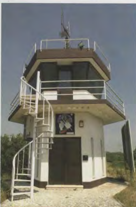
A estação de comando e controlo do PoSAT-1. No caso do satélite português as antenas não são parabólicas (a antena helicoidal é a de recepção, a que parece uma antena de televisão é a de emissão).
