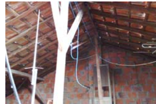
Fig.8 - Parede do prédio em tijolo e cimento.
